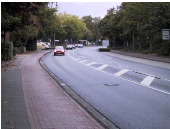
Bild 4-3: fehlende Überquerungshilfe an stark befahrenem Innenstadtring
