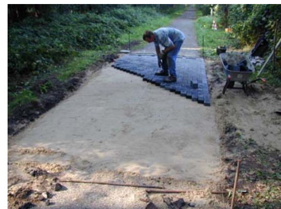
Bild 20: Pflasterarbeiten auf der Nordost-Route
