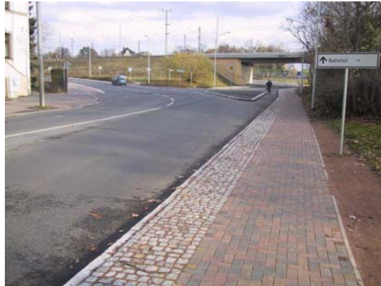
Bild 6-20: Radfahrschleuse mit einfachen Mitteln (Weserstr., ehem. B 187)
