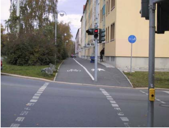
Bild 5-20: Beispiel für erste Markierungsmaßnahmen (August-Bebel-Str.)
